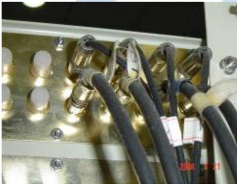
图3 某传输机房 DDF 架同轴电缆标签
